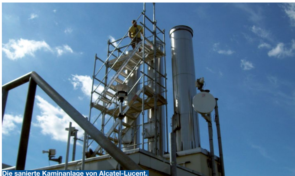
Die sanierte Kaminanlage von Alcatel-Lucent.
