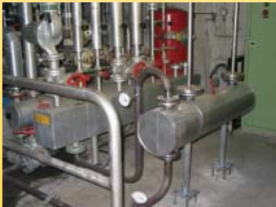
Heizraum Tanklager: Endmontage der Rücklaufvorwärmung
