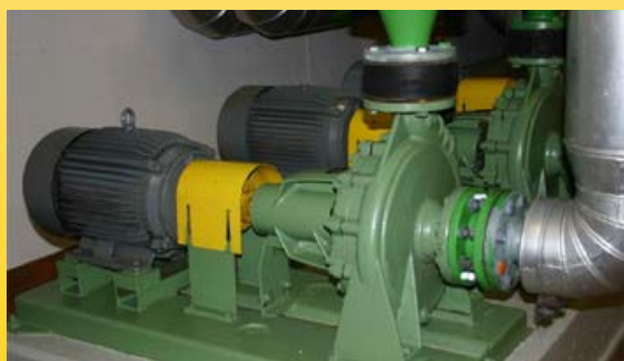
Sanierte Sockelpumpe
