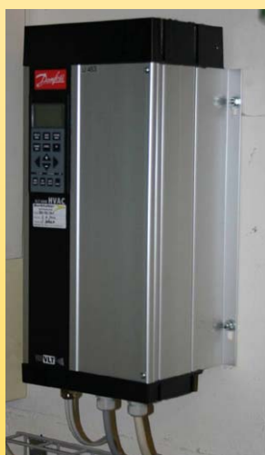
Nachgerüsteter Frequenzumrichter
